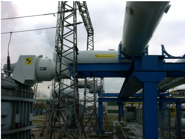
Podłączenie do transformatora Connection to transformer
